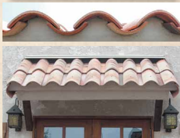
S型瓦【サブリエ工法】の軒先
