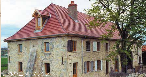
海外施工例：フランス
