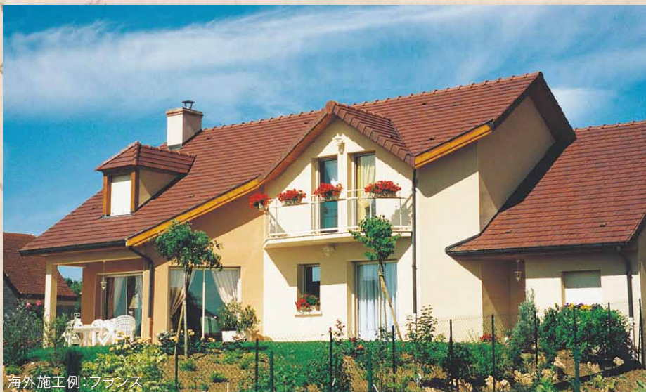
海外施工例：フランス
