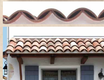
カナル瓦の軒先
