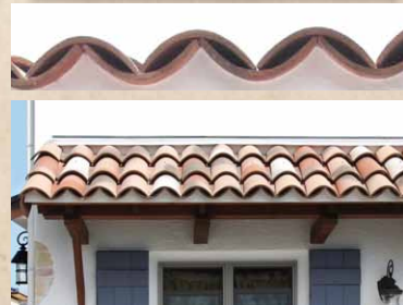
カナル瓦の軒先
