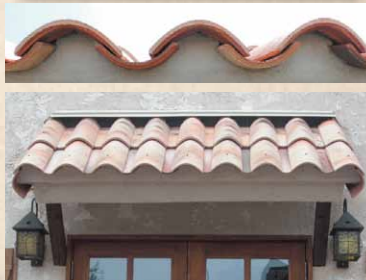
S型瓦【サブリエ工法】の軒先
